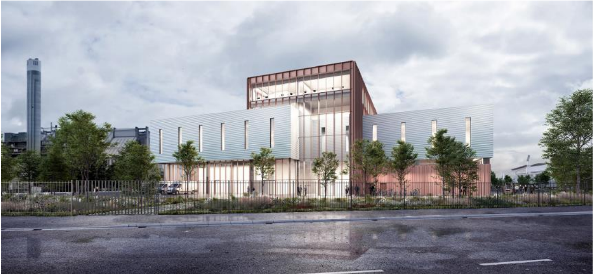
Vue de l'entrée depuis la rue de Dijon
