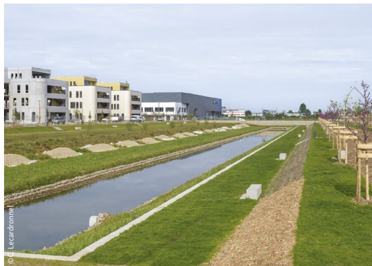
Bassin de gestion des eaux pluviales de la phase 2.
