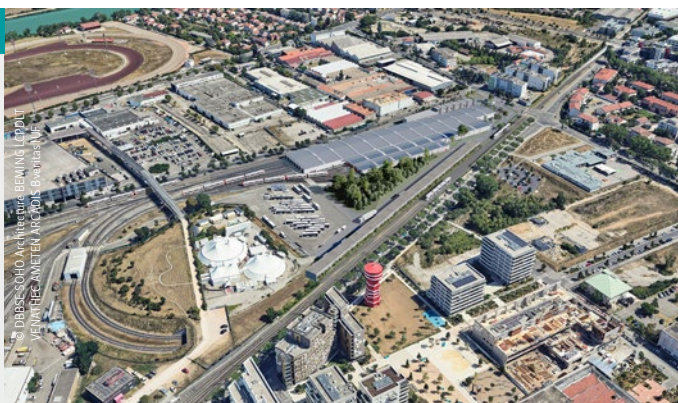
Perspective aérienne du projet d'extension du centre de remisage métros de la Poudrette.
