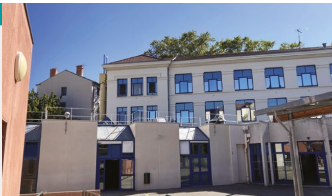
Collège Jean de Verrazane avant travaux - Lyon 9 e
