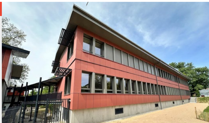
Photo du nouveau bâtiment d'enseignement
