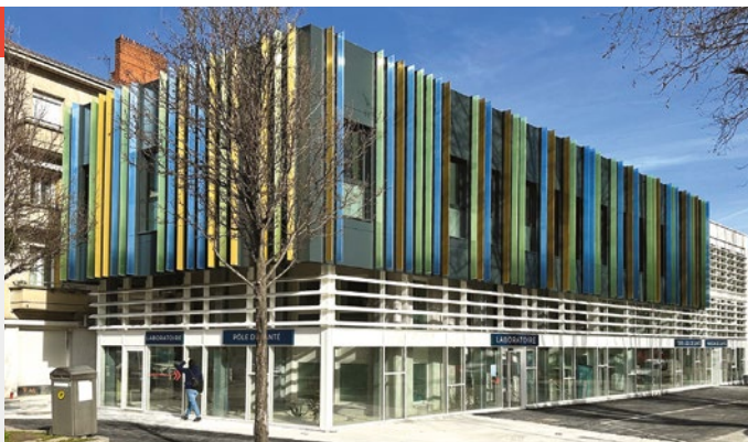
Vue globale du bâtiment.
