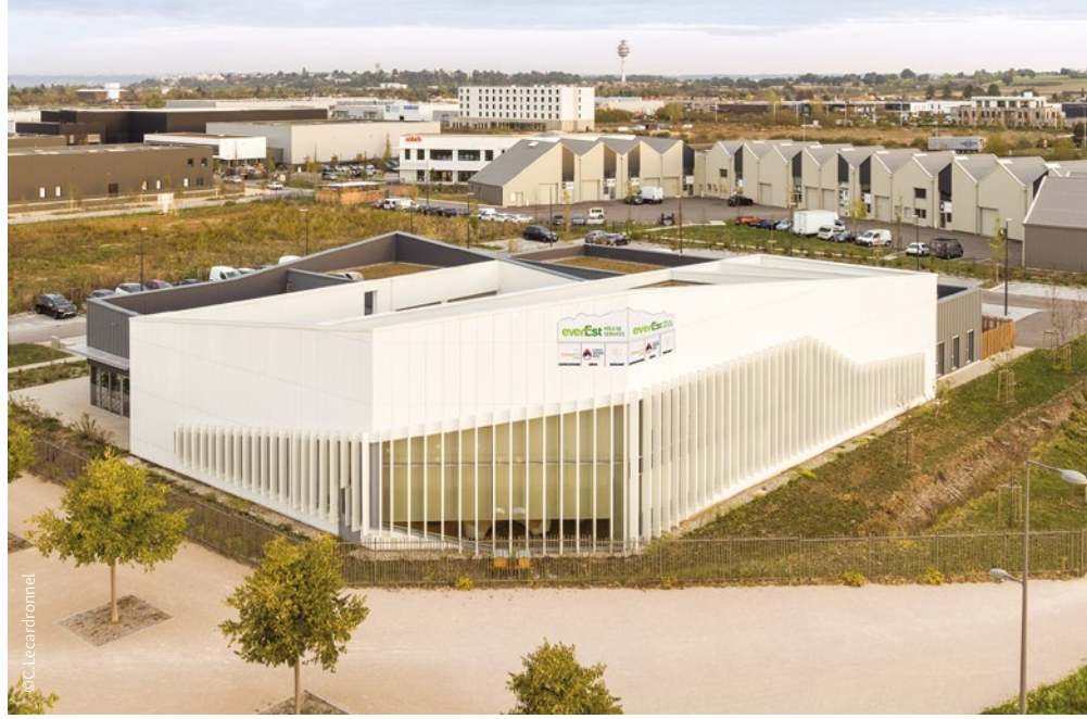
Pôle de services sur la ZAC Everest à Genas
