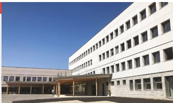
Collège Alain réhabilité
