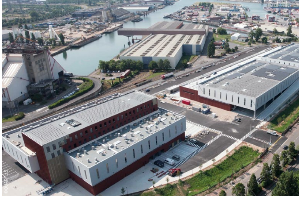
Vue aérienne de l'Hôtel de Logistique Urbain (HLU)
