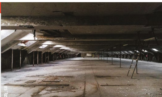
Espaces à réhabiliter ayant vocation à accueillir l'école de musique
