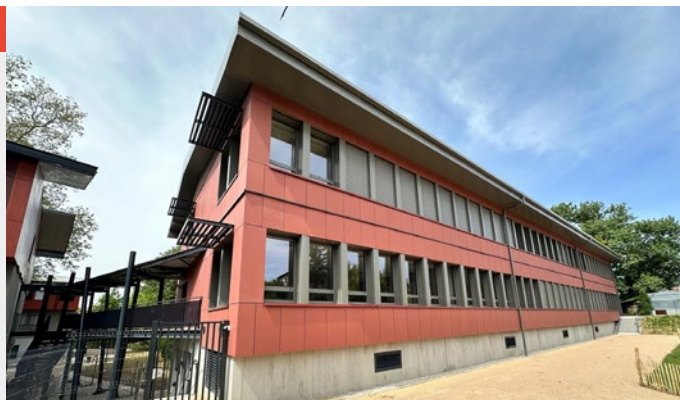
Photo du nouveau bâtiment d'enseignement
