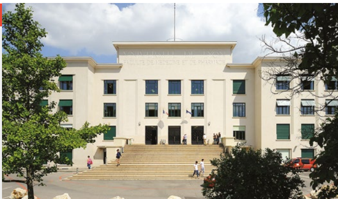
Entrée principale du bâtiment Bellemain réhabilité
