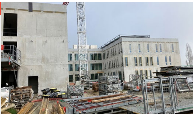
Chantier du futur établissement de pédopsychiatrie
