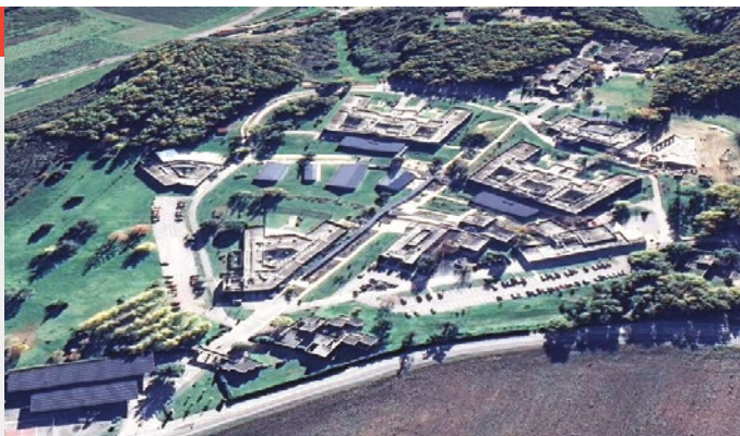
Vue aérienne du Centre Hospitalier Drôme Vivarais
