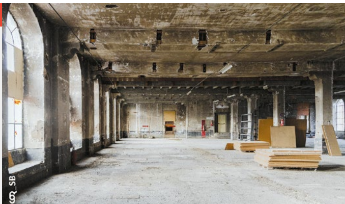
Espace du rez-de-chaussée du bâtiment historique à réhabiliter
