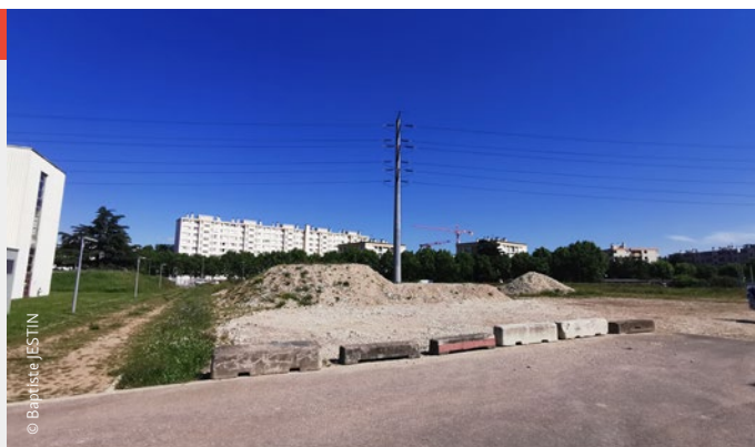
Emplacement de la future hall du LOT 4 du site USIN
