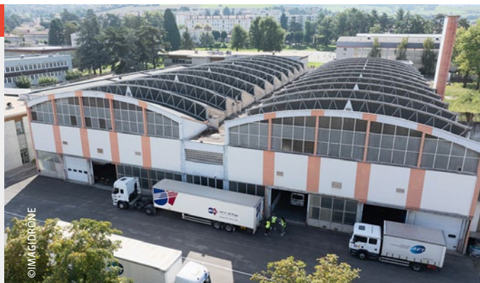
Vue aérienne de la cité scolaire Claude Lebois
